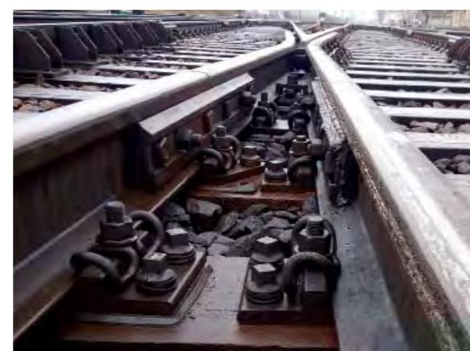
Устройства нанесения смазки представляют собой смазочные шины простой и надёжной конструкции, обеспечивающей равномерное распределение и долгое удержание смазочного материала в зоне проката (погружения) колёс.
