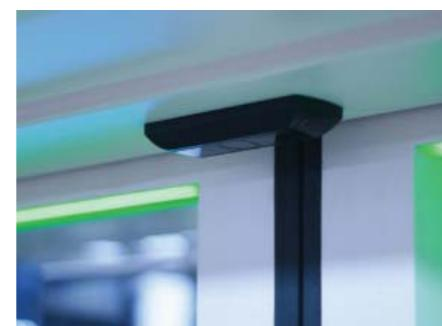
Рис. 3. Применяемый бесконтактный датчик автоматического подсчета пассажиров на технологии Time of Flight (радарный принцип измерения расстояния до объекта в 500-х независимых точках в инфракрасном диапазоне)
